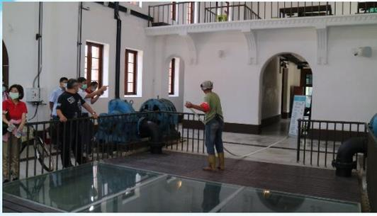
個園區將來自曾文溪的原水過濾之後，藉由加壓馬達，送到附近的淨水池，利用 60 公尺高度落差的重力加速度，送往臺南市區，供應約 10 萬人的用水。運作 1 甲子(60
