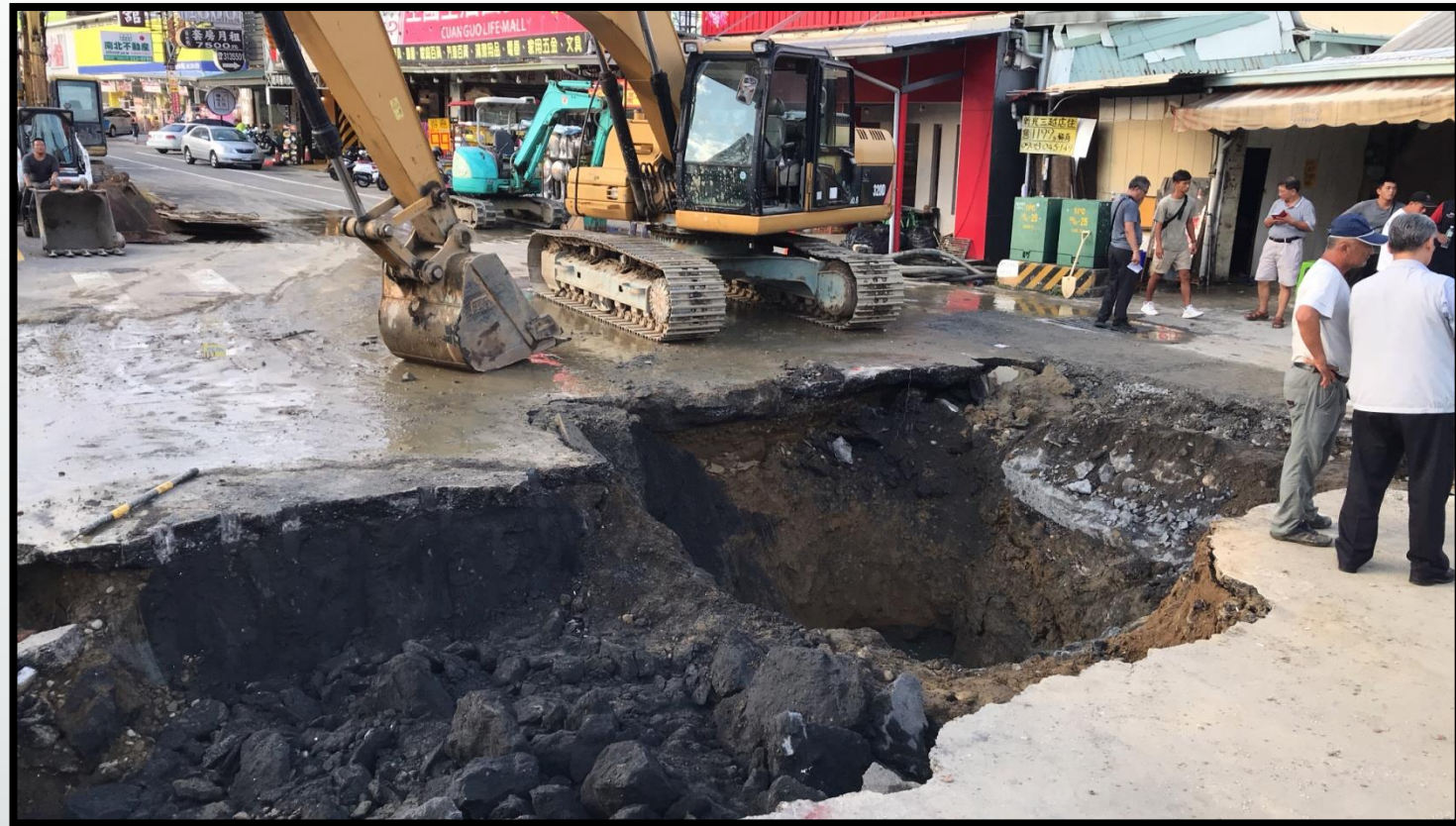
側溝端找尋聯通管位置
