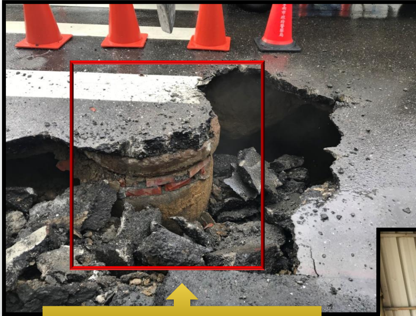
未知集水井露出
