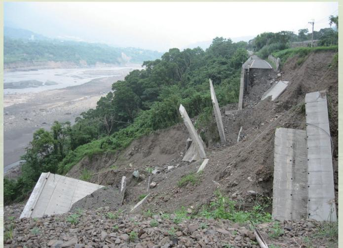
擋土牆因邊坡坡趾掏刷而破壞
