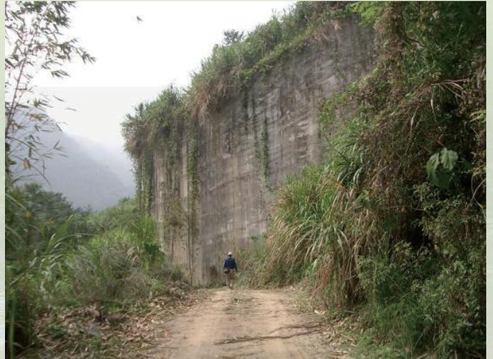
擋土牆高度太高水平抵抗而位移
