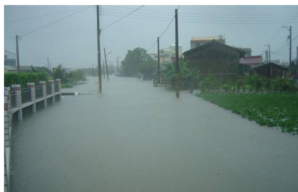
仰安堂前中排溪水暴漲災害相片
