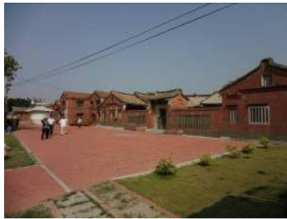
彰化大有社區 修繕後之相片
