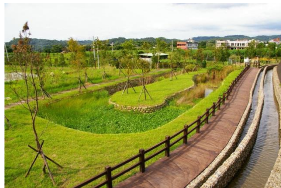
龜丹溪、後旦溪竹圍段河堤整治 以生態工法施作示意圖
