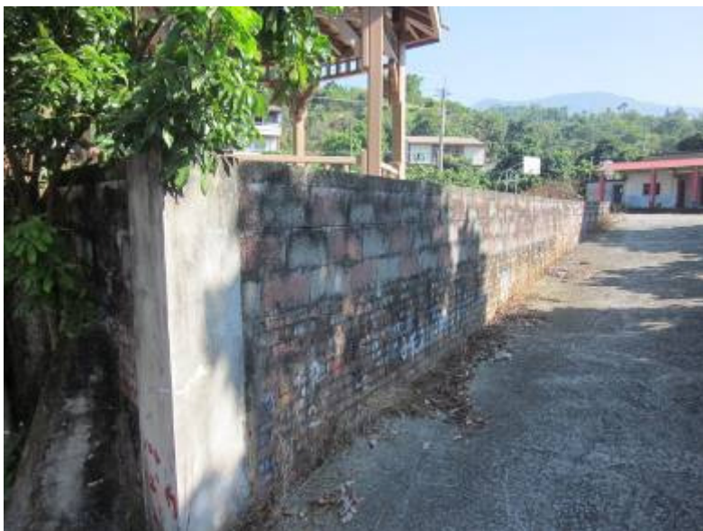
水井公厝擋土牆美化
