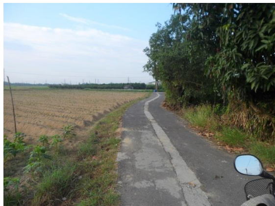
社區巷道路面不良路段現況
