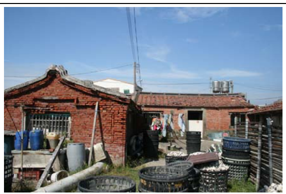
照片 31 傳統建築空屋修繕
