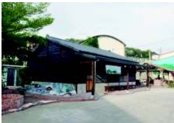
修繕後西側樣貌
