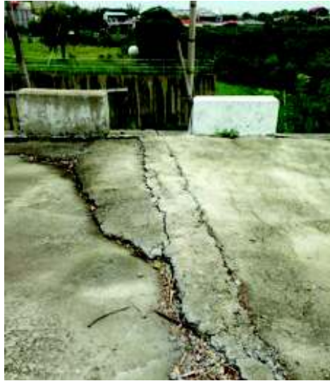
圖48. 社區路面改善及排水系統整治工程處現況
