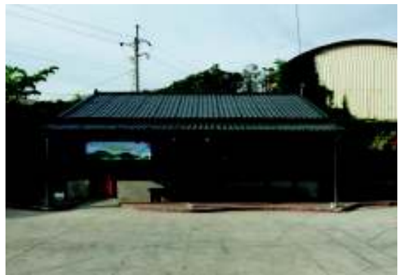
大崎兒童藝術圖書館(舊中山堂) - 外部修繕完成
