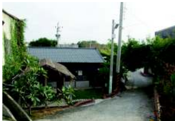
修繕後北側樣貌
