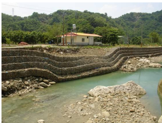
河堤現況照片
