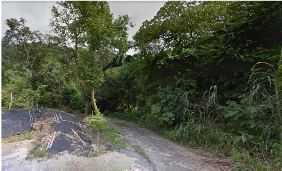
產業道路修繕
