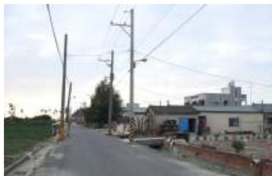
縮，北側排水溝（五塊寮小排三之十一）溝面變寬，最寬近 2.5 公尺。並未設置車檔設施，影響居民出入安全。此問題困擾社區已久，目前大多居民主張於此路段排水溝施作水泥加蓋，以便同時達成通行安全與路面拓寬的目標，也方便至唐明殿進香的遊覽車與刈香陣頭通行。然而排水加蓋後，將造成清淤不便的問題。98 年莫拉克颱風中，許多大型垃圾、甚至體積較小的漂流木都隨水流衝進這條排水路，造成溝面壞損或淤塞，因此加蓋的作法，或應待商榷。
