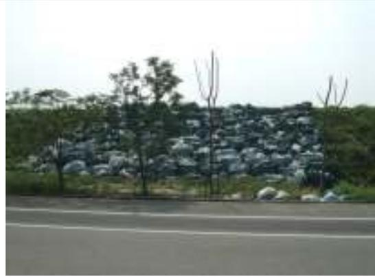
98年8月8日當天曾文溪九塊厝堤防永吉-十份段堤防結構體多處久已破損，地方民防立即向鄉公所請求支援，以沙包強固堤防結構體。
