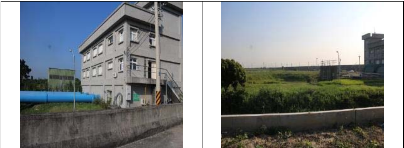
圖 43 抽水站及周遭環境現況
