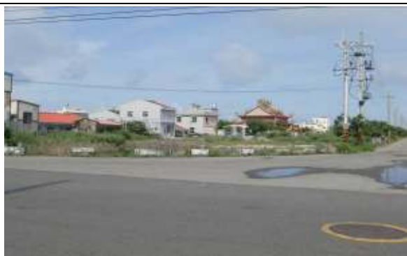
南區十五與南區十交叉路口袋公園 對面濕地
