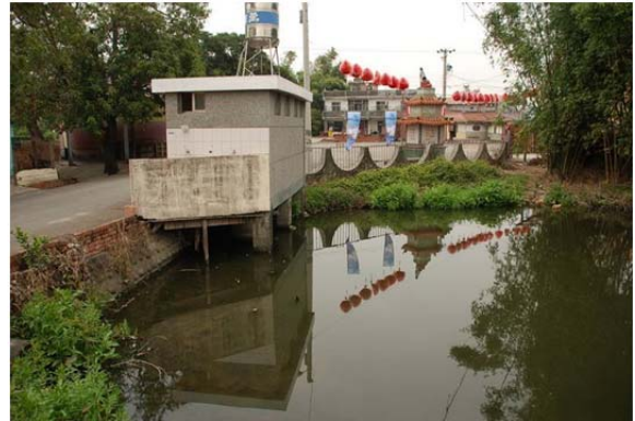
圖 4-16 埤畔廁所現況
