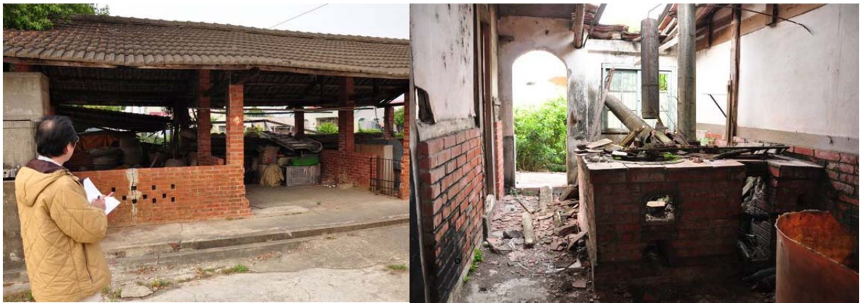
圖 4-20 岡村晶義建築師現場勘查照片。
