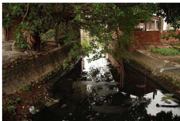
圖 4-12 土溝溝岸斷面現況照片一
