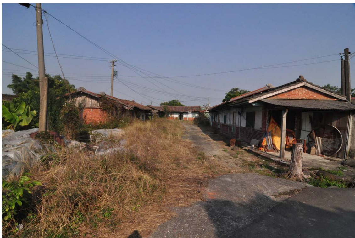
圖 2-42 頂土溝聚落內無人居住的传统建築
