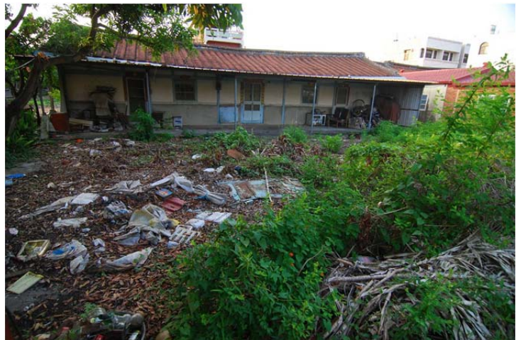
圖 4-36 建築現況照片
