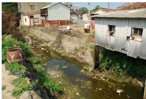
圖 4-13 土溝溝岸斷面現況照片二
