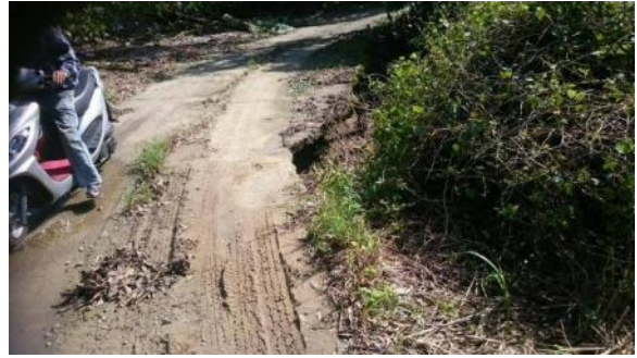
張家古墓道路掏空塌陷
