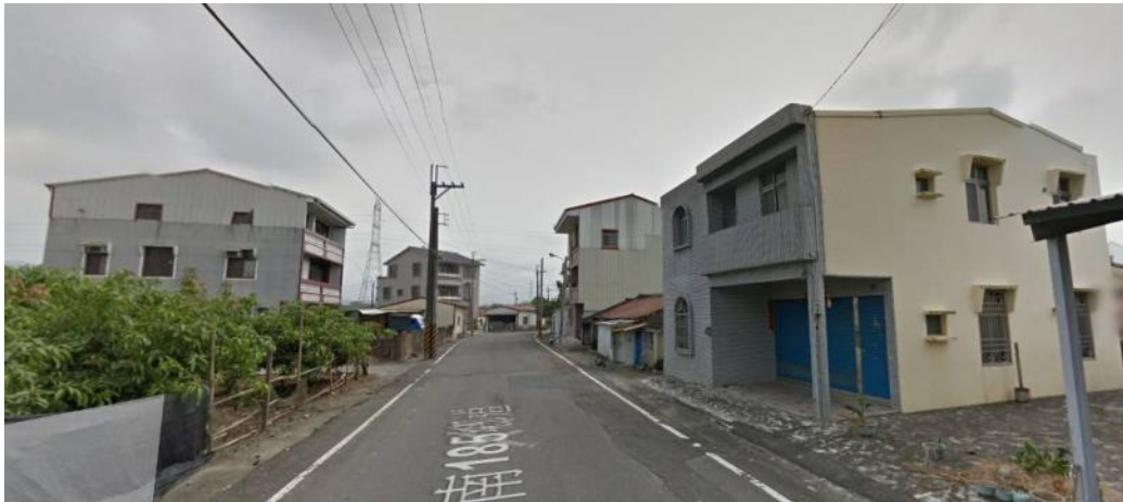
鋼筋混凝土（RC）式樓房住宅
