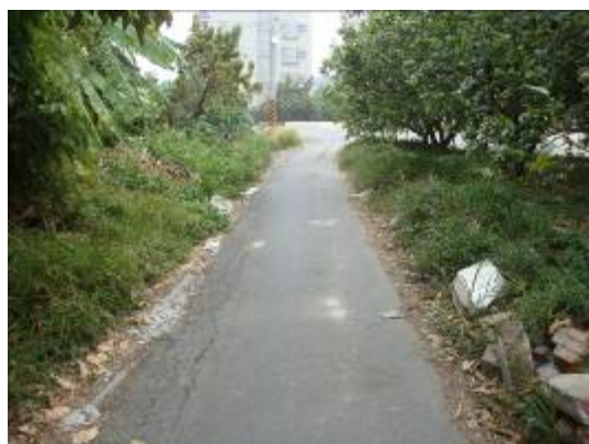
1-6 南 173 線進虎尾寮入口
