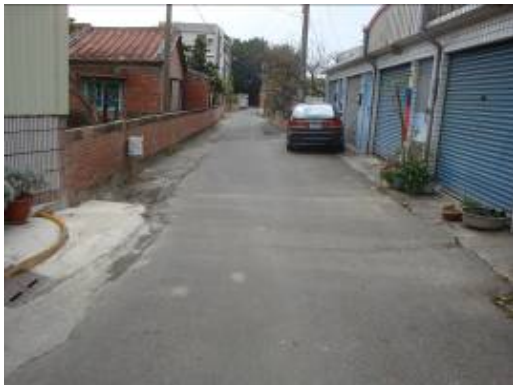
2-1 春木巷道西邊砌溝改善工程
