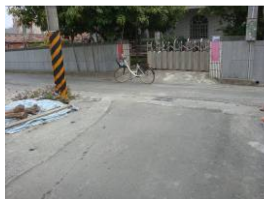
2-2. 真寶厝前排水改善工程
