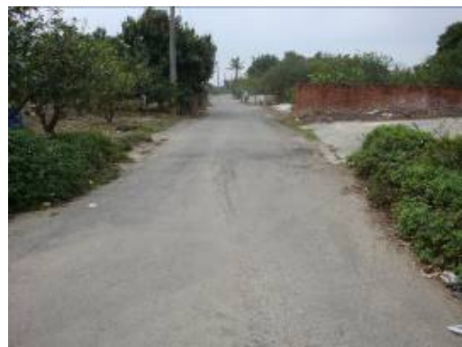
2-7. 長青往 44 號-25 農路改善工程
