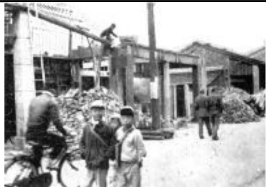
新市區新市里139號磚造二層旅社倒塌。
