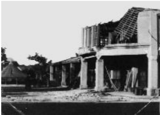
新市區新市里被毀之樓房(1946.12.06 攝，根據張麗旭等(1947)，陳培源教授提供)
