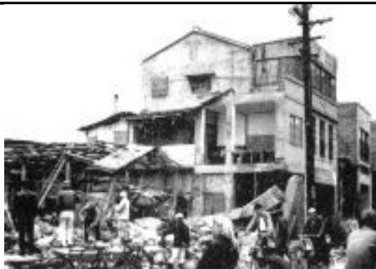
新市市場，鋼筋混凝土柱木造房屋 傾塌，水泥柱壓倒隔壁鋼筋混凝土 柱。
