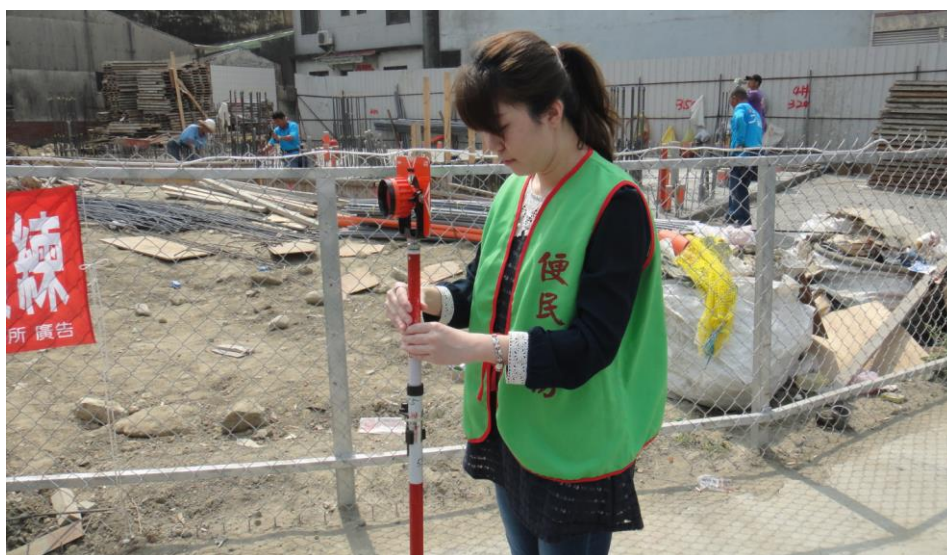
圖 14：本所女性測量員持標桿協助測量地面位置（幸福大樓原址）
