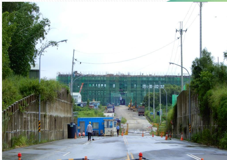
校區工程(大門)
