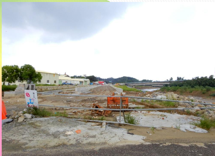
校區連外道路(許縣溪旁工程 興建中)
