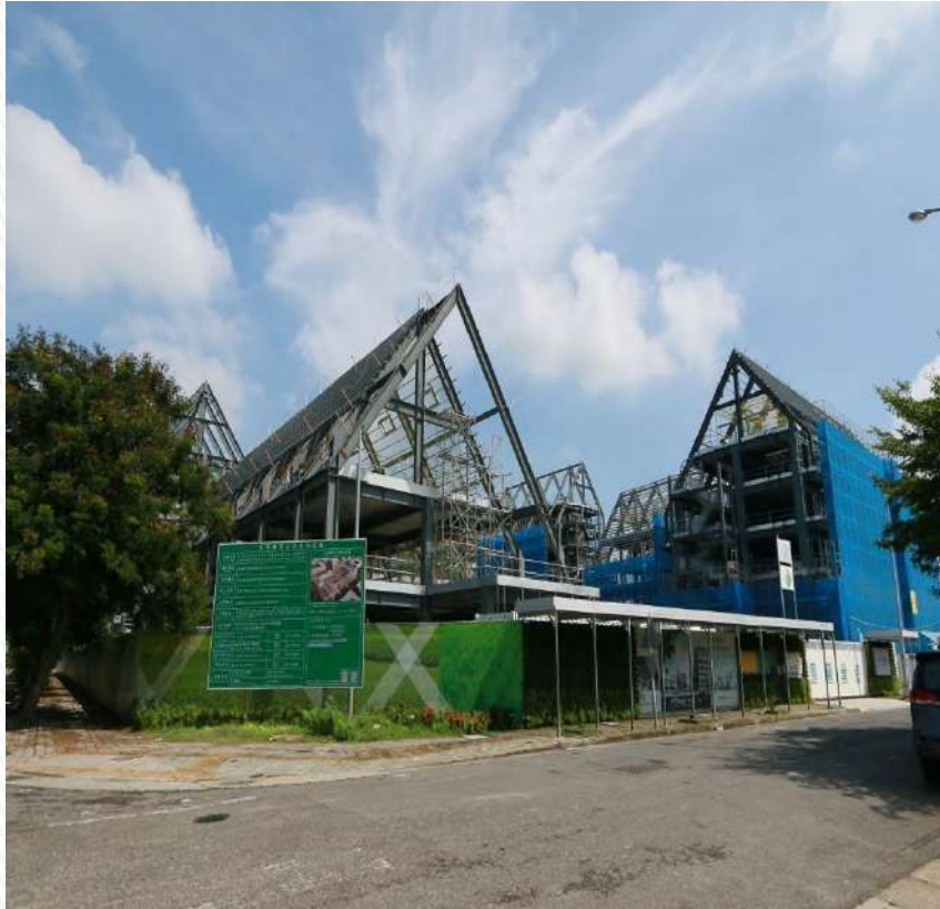
台糖綠能循環住宅
