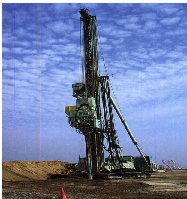
圖 4.3 擠壓砂樁地盤改良工法示意圖
