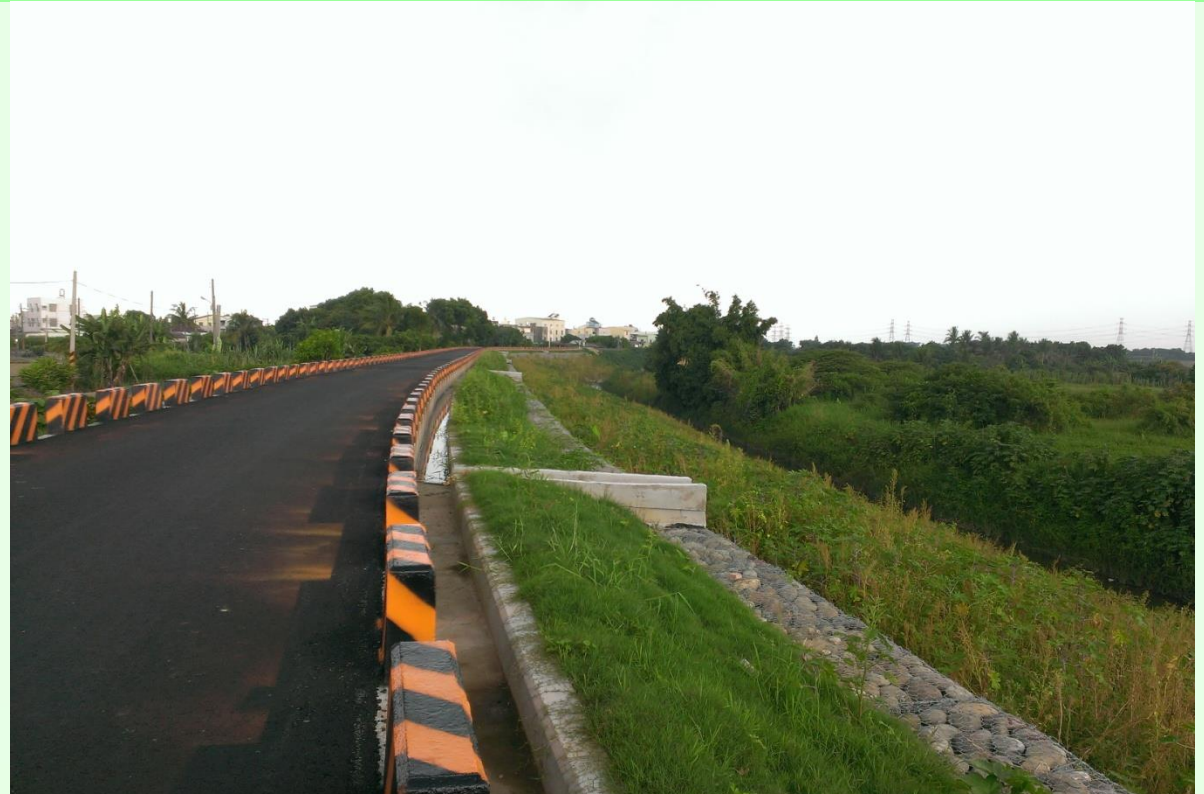
溪尾排水整治工程
