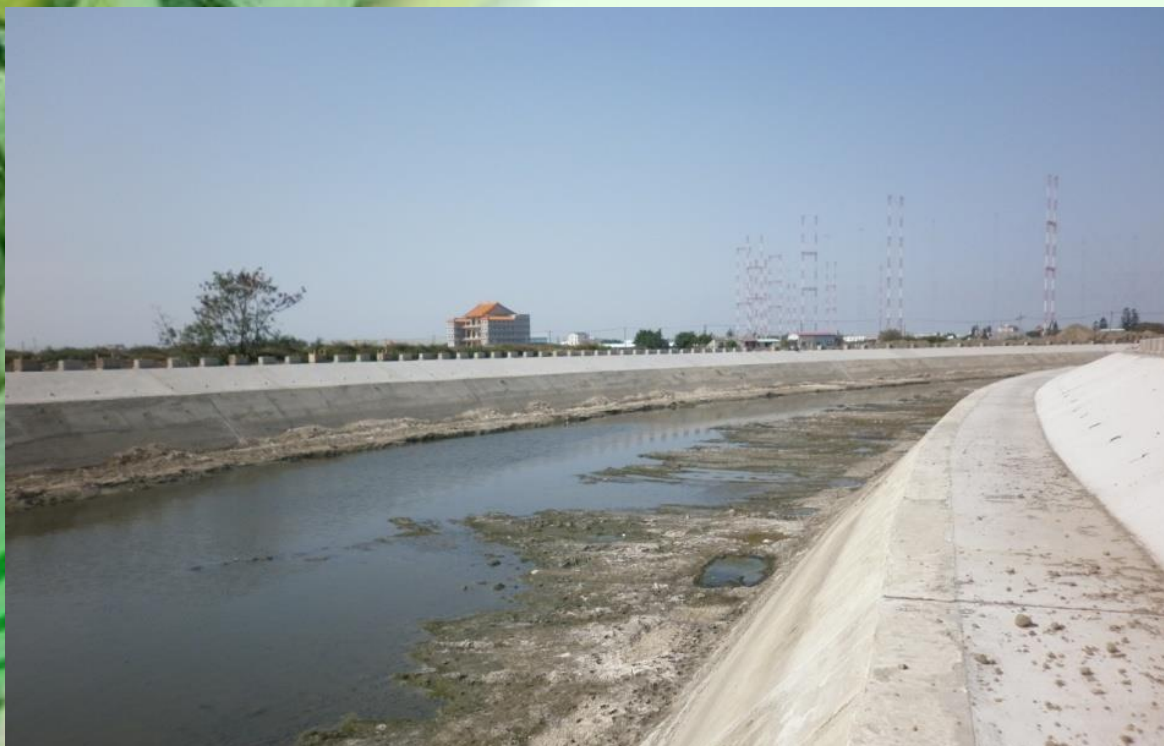
本淵寮排水整治照片
