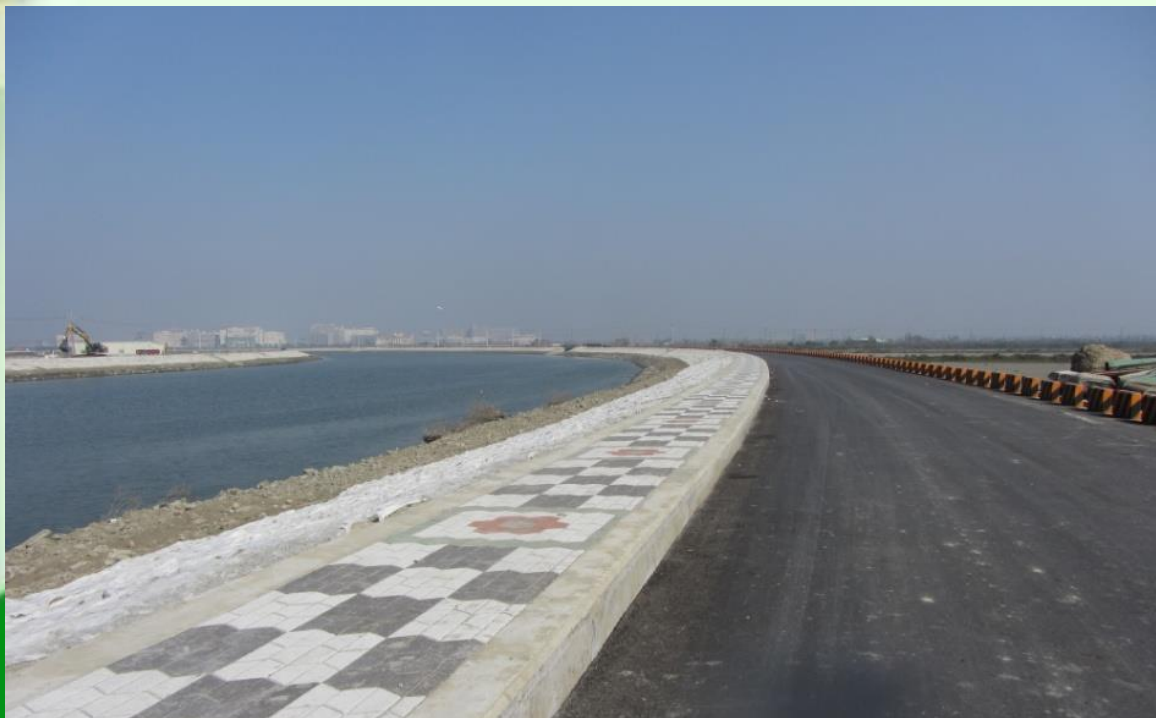
曾文溪排水起點至海尾寮排水匯流口 段整治工程(左岸)
