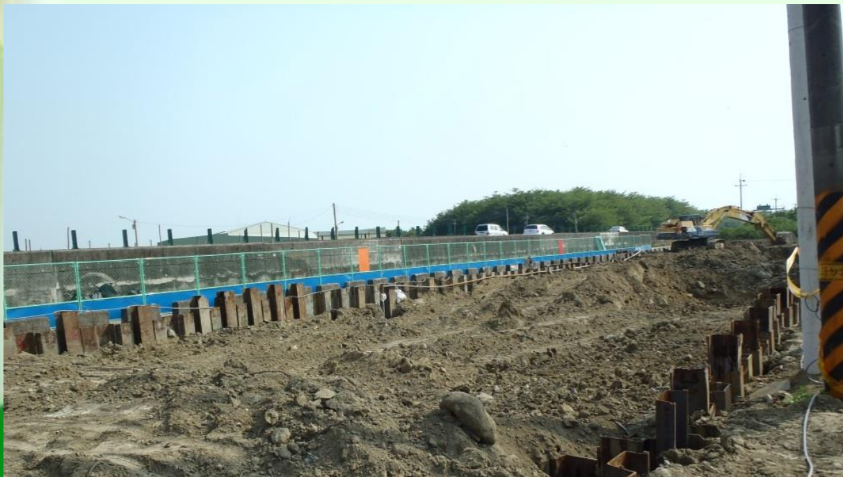
仁德滯洪池以南左岸抽水站 與抽水平台工程
