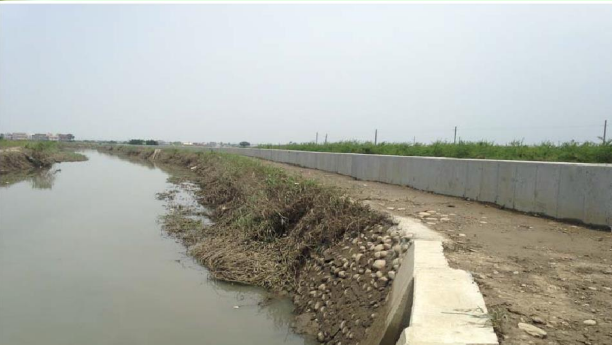
埤頭排水應急工程(小埤頭橋)
