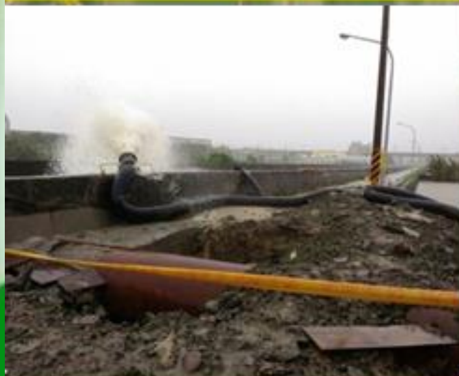
新市衛生抽水站增設施工中
