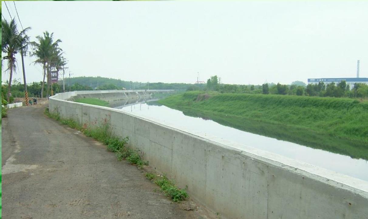
三爺溪排水萬代橋至文賢橋段 左岸加高應急工程
