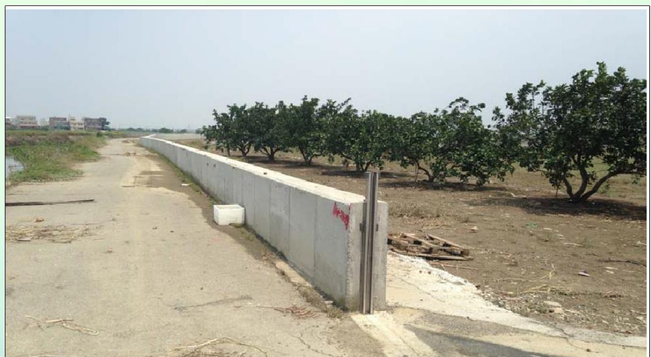
埤頭排水應急工程(小埤頭橋)
