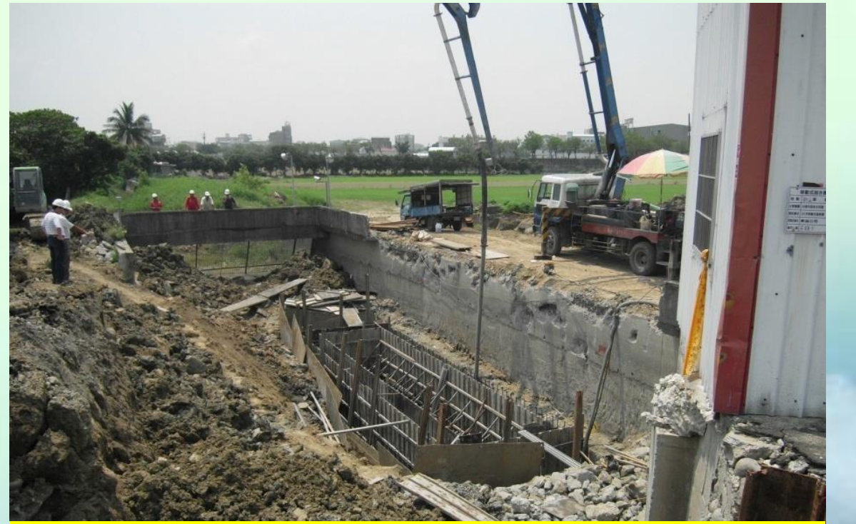
新市衛生抽水站擴建工程
