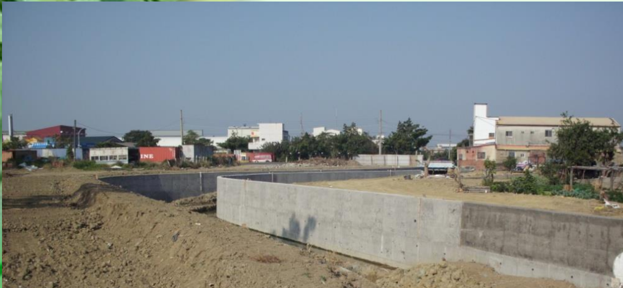
柳營區南八老爺排水(柳營路東側)改善工程
