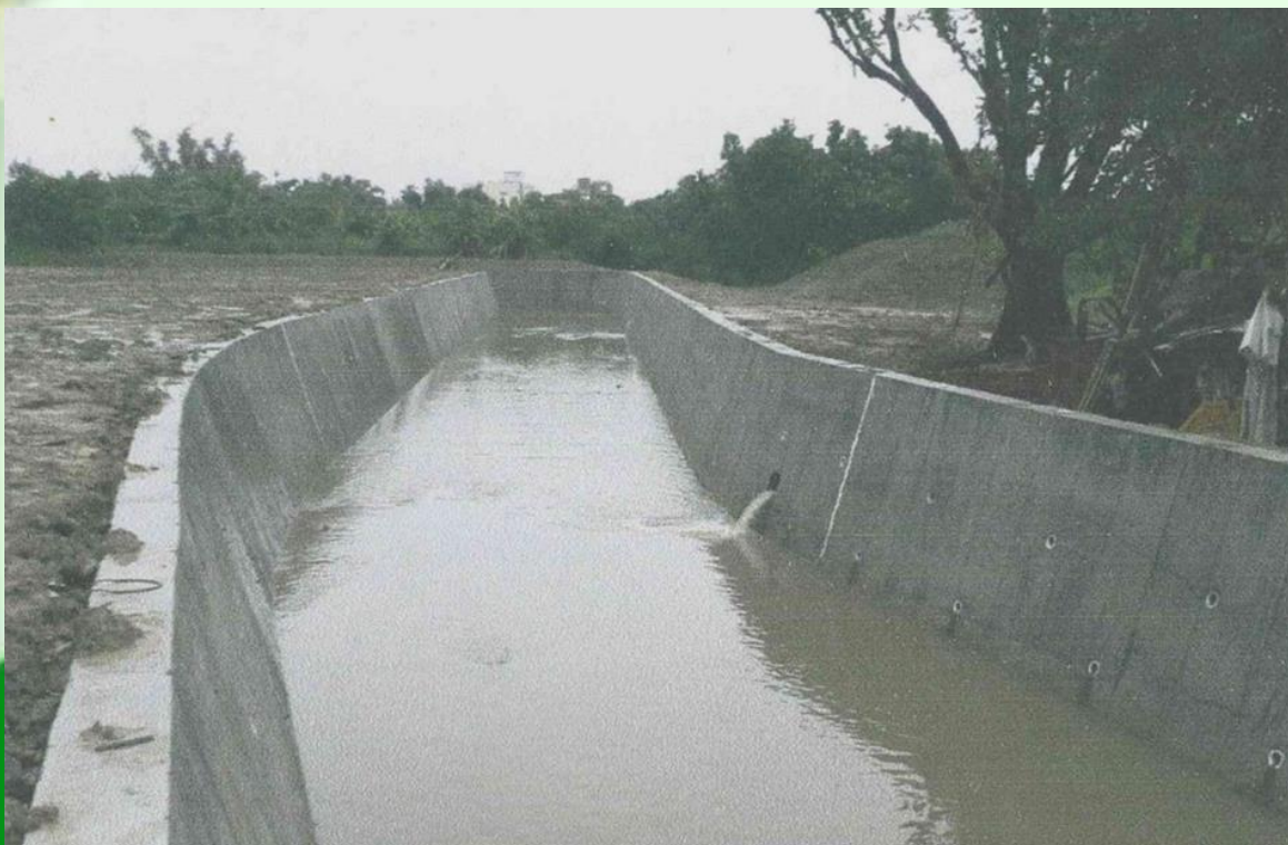
新化區啟聰溝排水護岸應急工程
