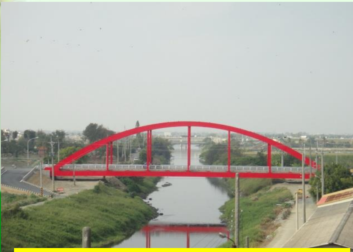
麻豆排水大溪橋改建工程
