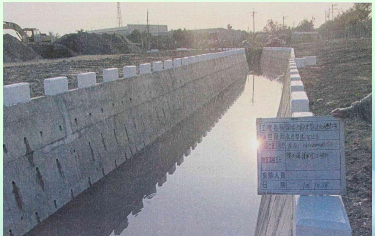
歸仁區沙崙武東窩仔底排水應急工程
