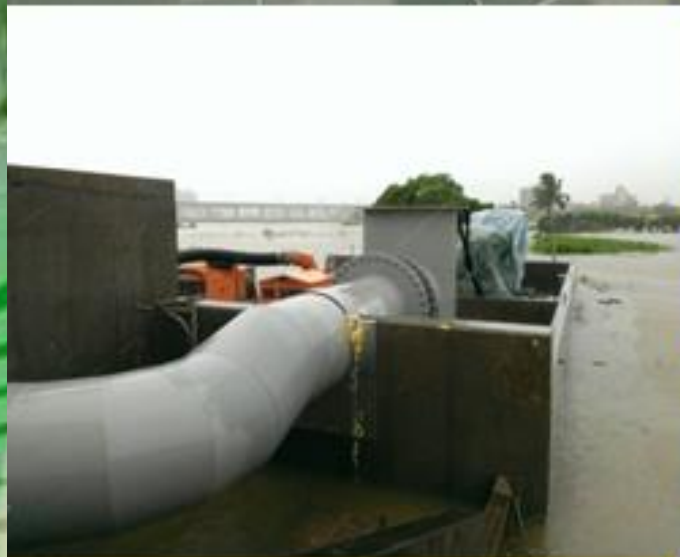
康芮颱風期間設置移動式抽水機兩台將水由新市衛生排水抽至新市排水之情形
