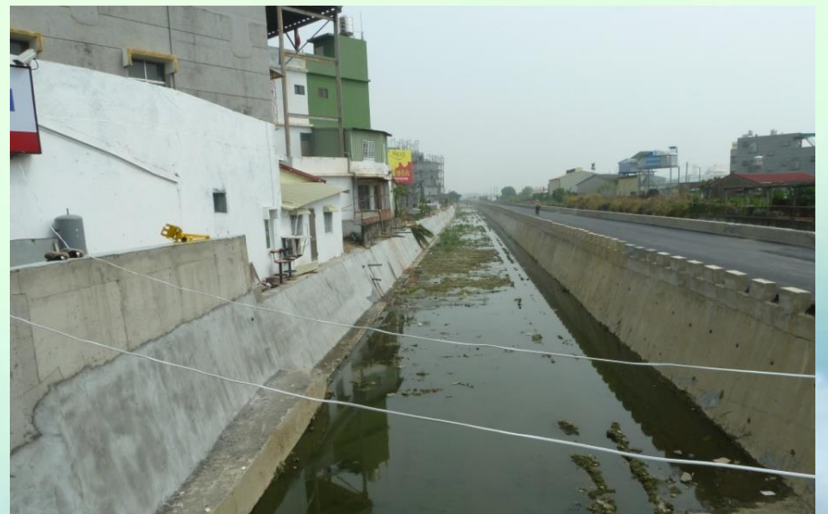
安定排水整治工程
