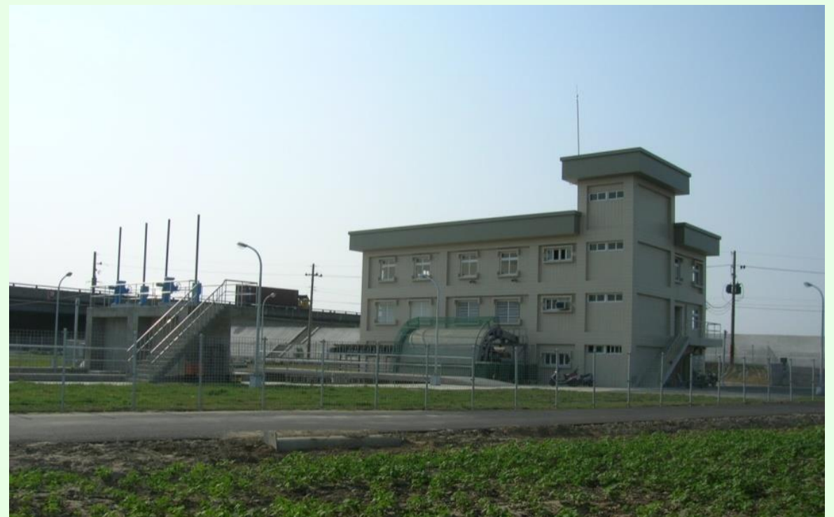
安定抽水站新建工程
