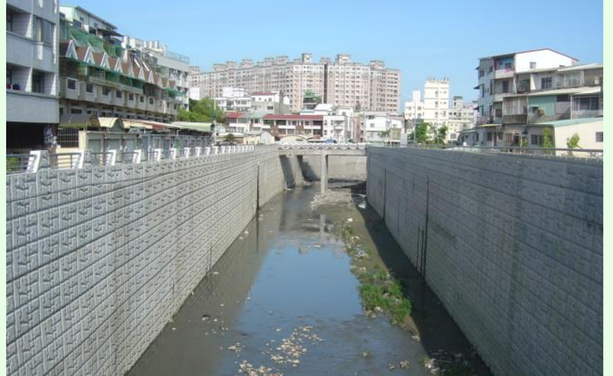
柴頭港溪排水南康橋至鐵路橋段整治工程
