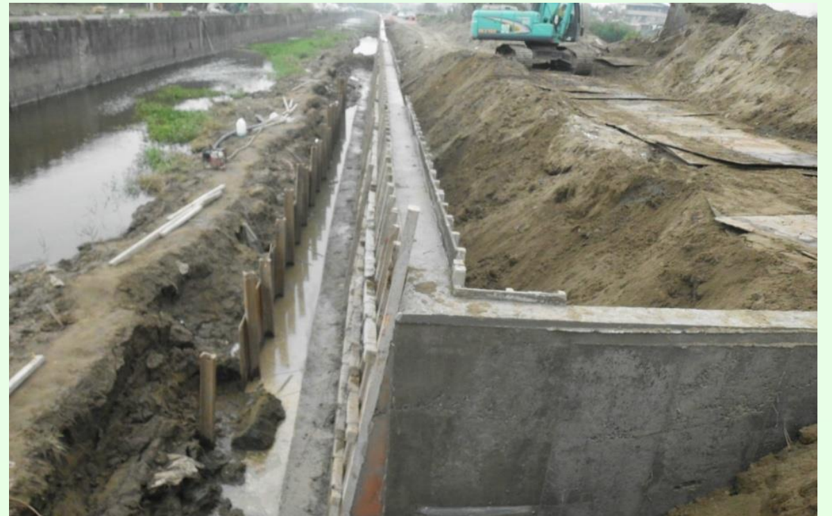
溪南寮排水應急改善工程
