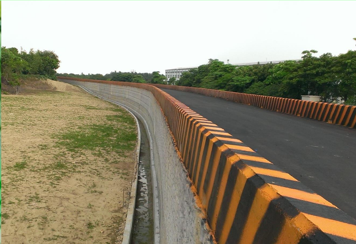
溪尾排水整治工程
