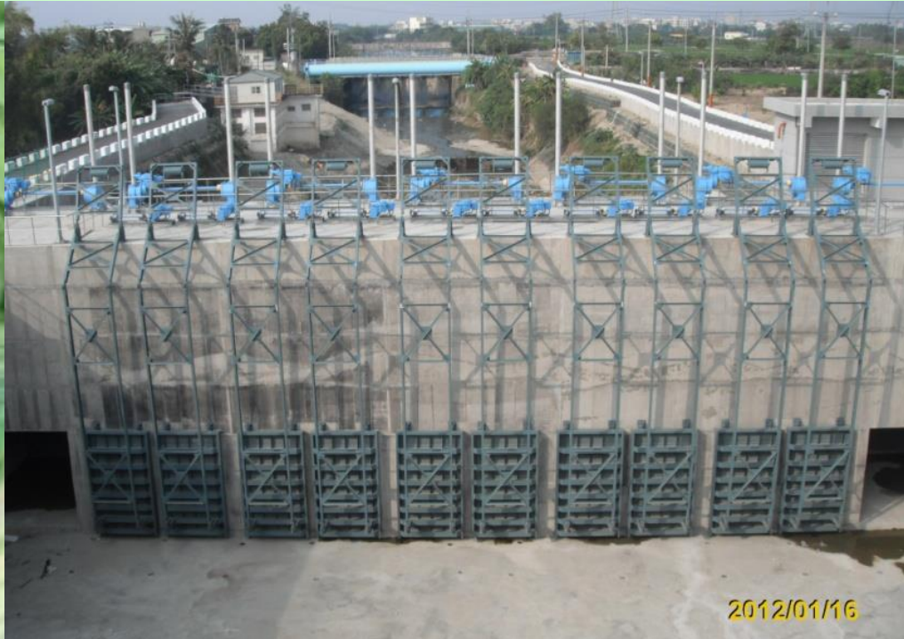
番子田排水閘門新建工程
