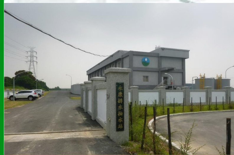
永康排水抽水站情況
