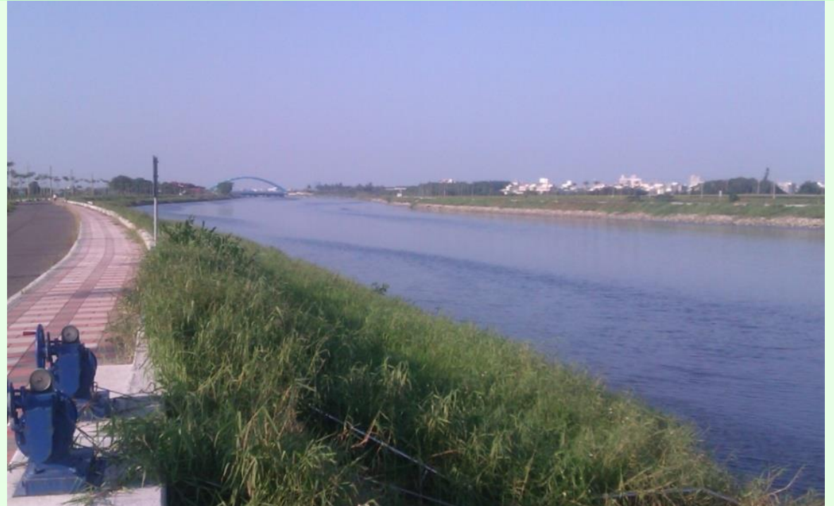
麻豆排水華宗橋至溪洲橋段
