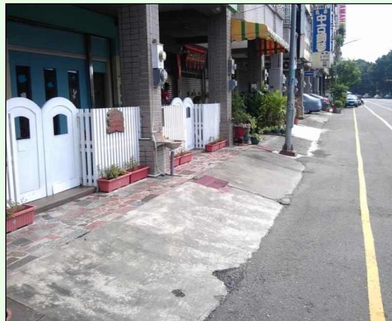
新進路一段住家排水溝 位置離路面20CM
