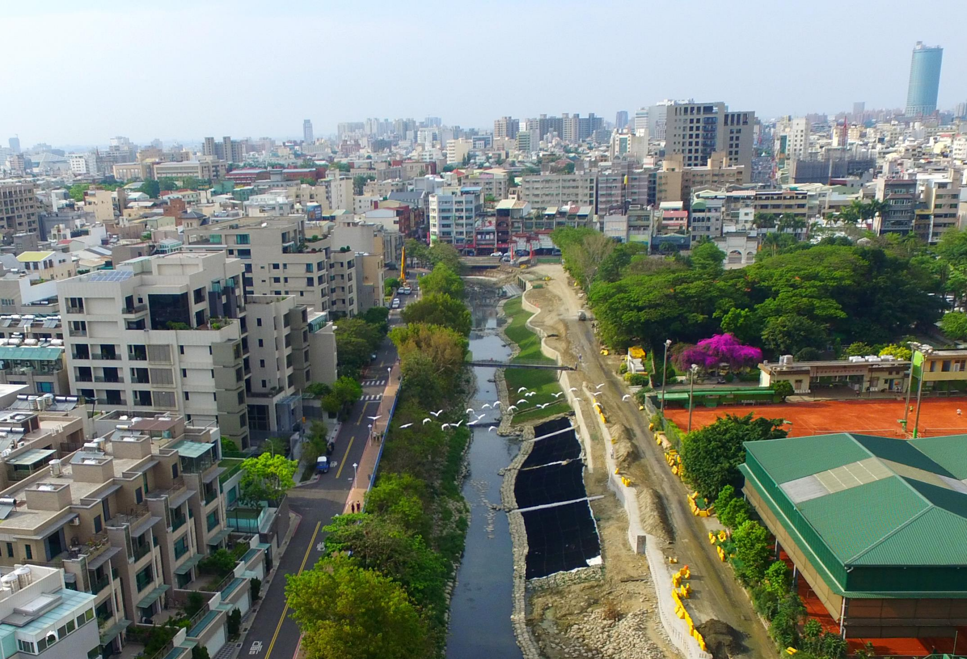
竹溪一期水岸施工中，河岸生態逐漸恢復
