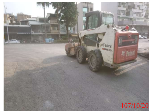
工區出入口粉塵清除
