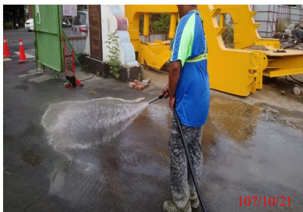
工區出入口地面清洗
