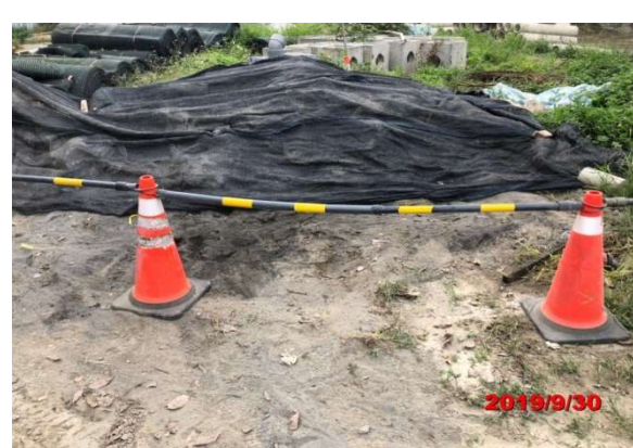
土方堆置覆蓋防塵網
