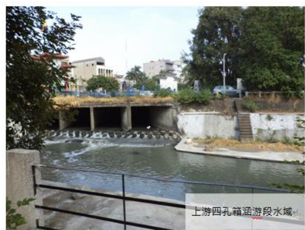
竹溪現況照片
