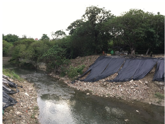
竹溪橋下游段流域邊坡環境照
