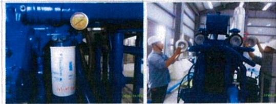
1 號抽水機機油濾心更換後
