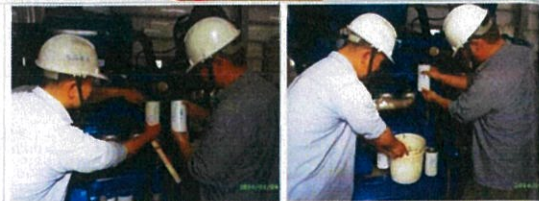
1 號抽水機機油濾心更換前
