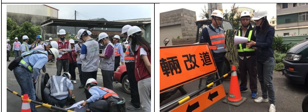
本局女性同仁辦理污水下水道工程現場查核及督導照片
