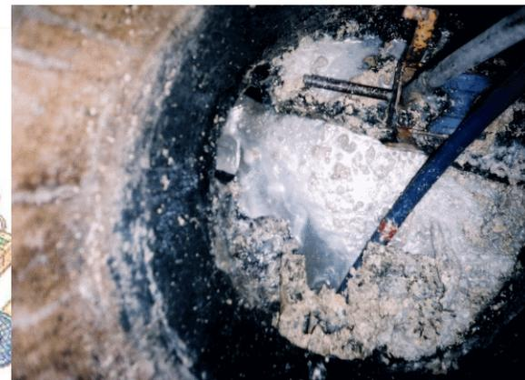
下水道受油脂、殘渣阻塞情形
