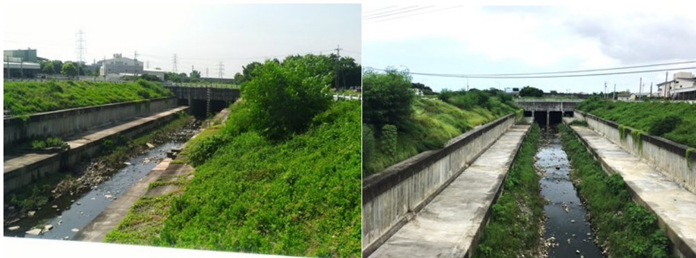
圖 5、港尾溝疏洪道水體現況
