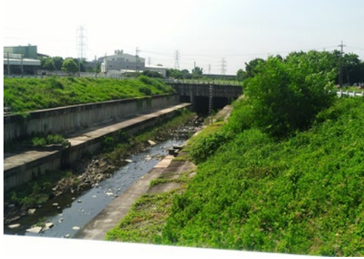
疏洪道邊坡植被
