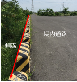
管線架設於場內道路護欄上
