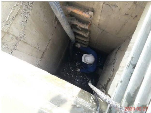
照片3：土庫路既有抽水井會勘 (民國109年2月27日)
