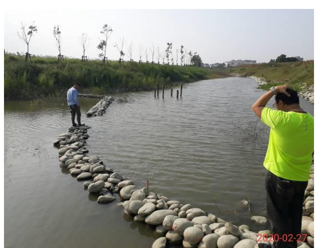
照片6：土庫路既有抽水井會勘 (民國109年2月27日)
