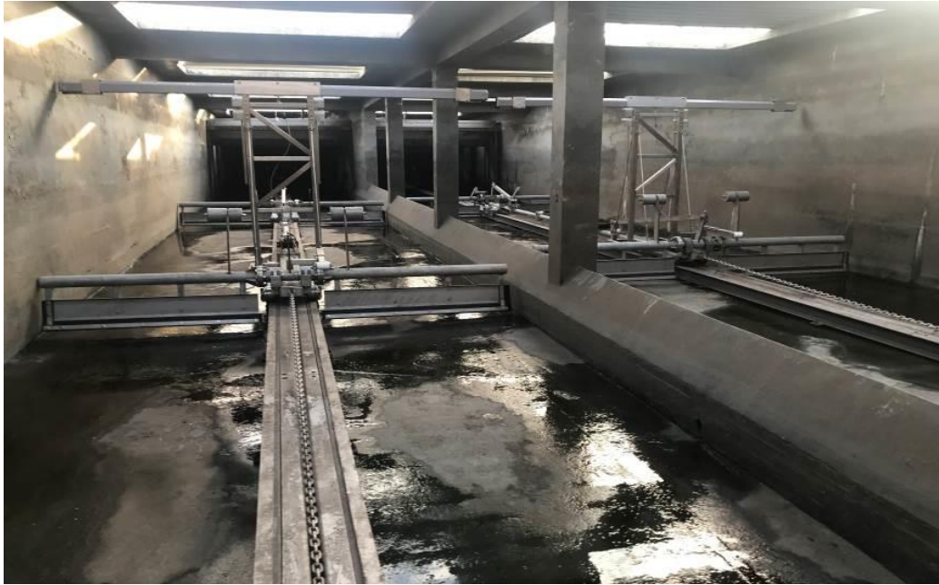
刮泥機安裝完成照片
