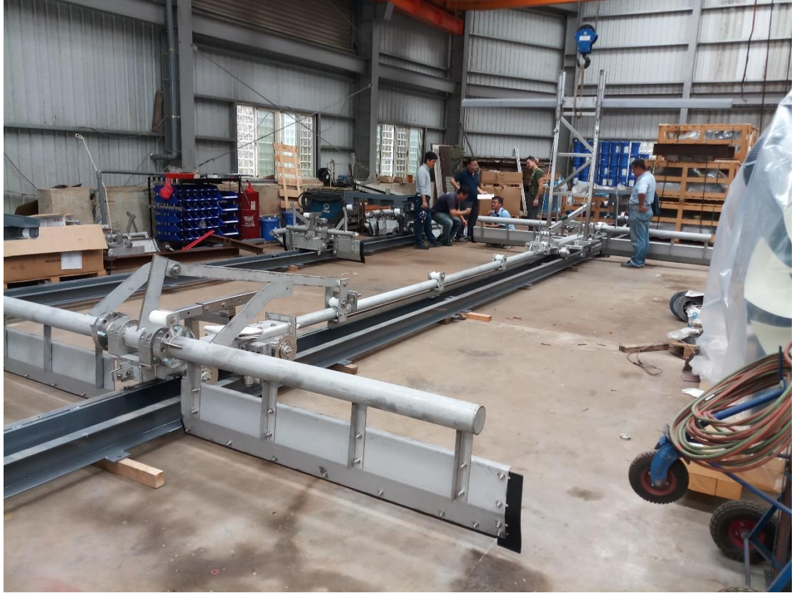
「刮泥機刮板、軌道、輪軸」構件工廠假組立照片
