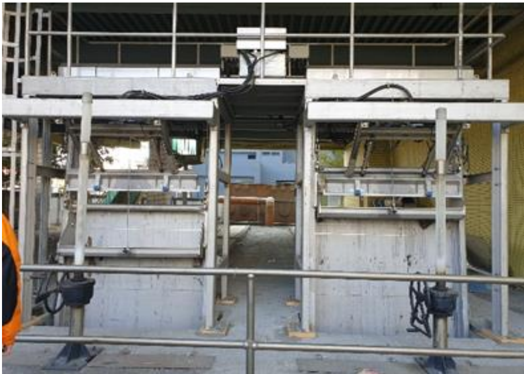
截流站撈污機安裝完成照片
