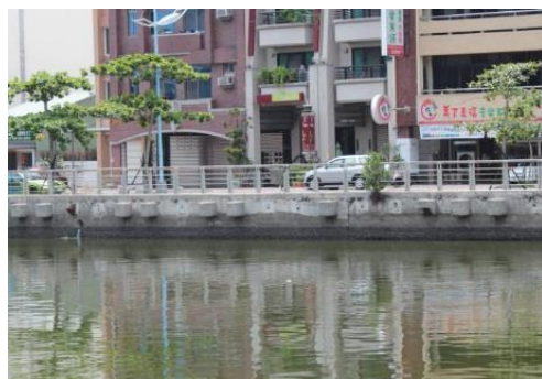
望安橋~臨安橋 (北岸-鄰安平路)
