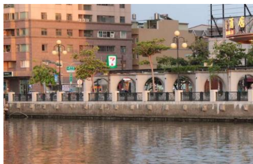
承天橋~望月橋 (南岸-鄰慶平路)
