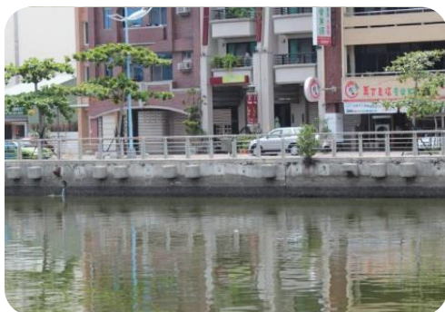
望安橋~臨安橋 (北岸-鄰安平路)
