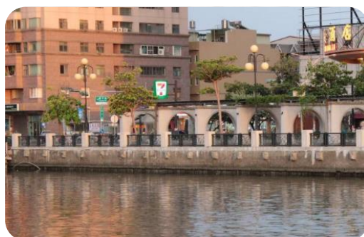
承天橋~望月橋 (南岸-鄰慶平路)
