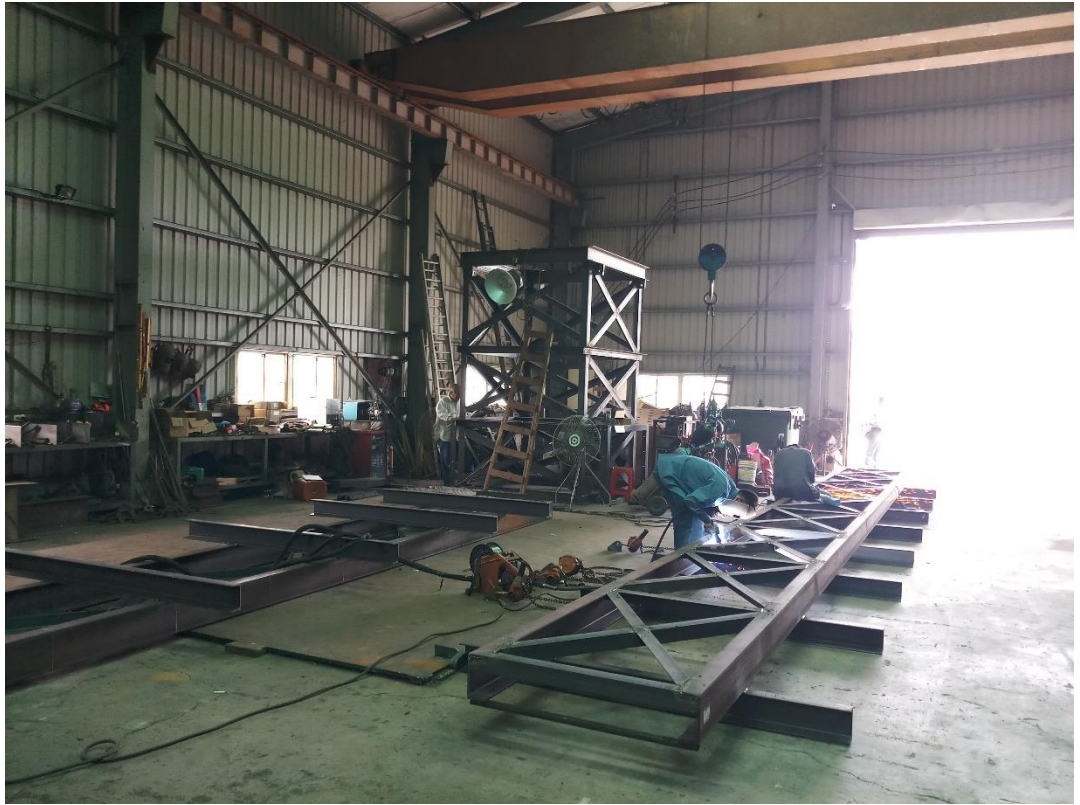
「中心柱」構件工廠加工照片
