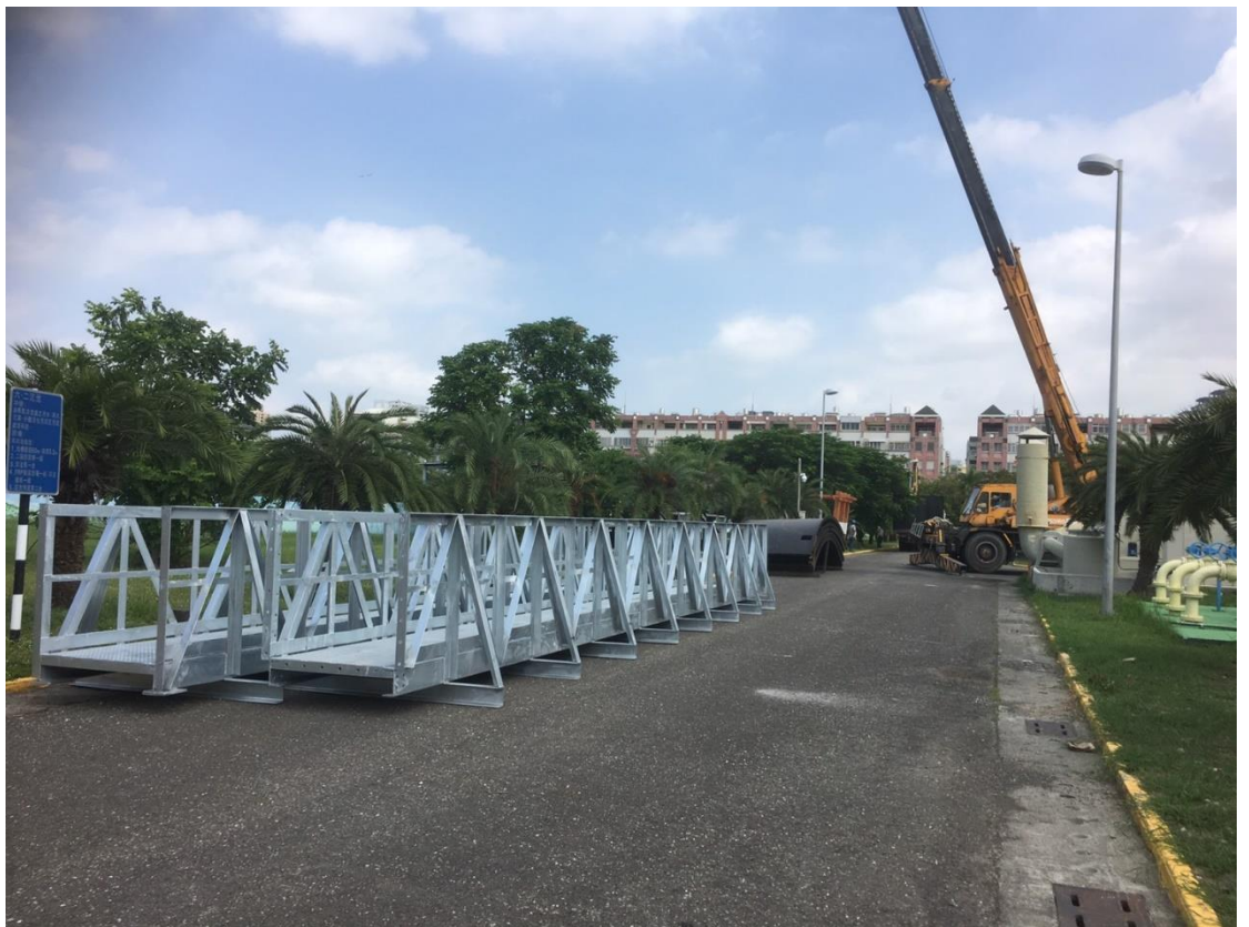
「走橋」等構件現場吊裝照片
