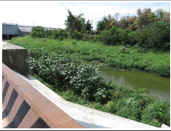
北側溪尾排水
