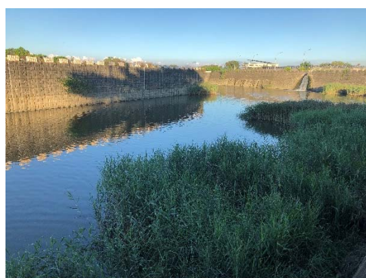
排水溝環境照
