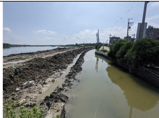
部分排水路已開挖 (拍攝日期 110 年 7 月 21 日)
