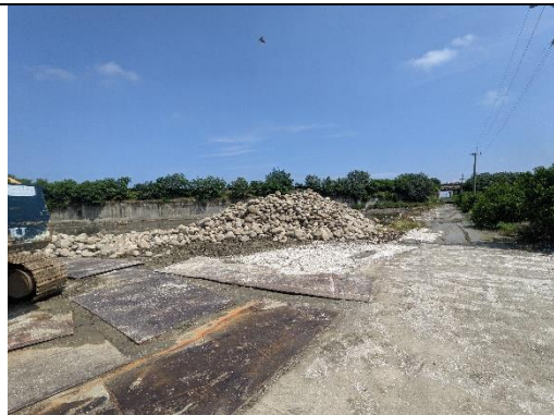
資材集中堆置區 (拍攝日期 110 年 7 月 21 日)
