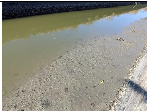
退潮時可見渠底泥灘地 (拍攝日期 110.12.28)
