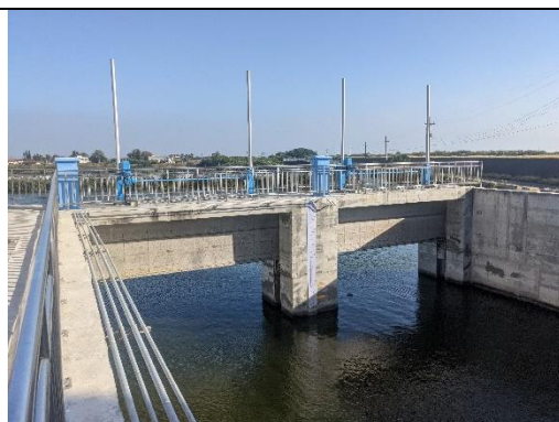
新圍抽水站之閘門 (拍攝日期 110.10.25)
