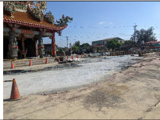
周緣之廟宇及已復原之路面 (拍攝日期 110 年 11 月 17 日)
