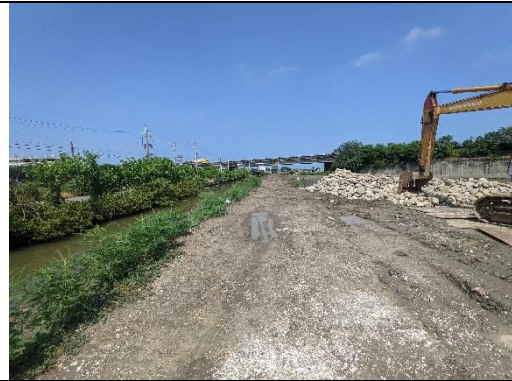
既有道路做為施工便道 (拍攝日期 110 年 7 月 21 日)
