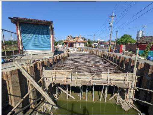
正在進行暗渠加蓋 (拍攝日期 110 年 11 月 17 日)
