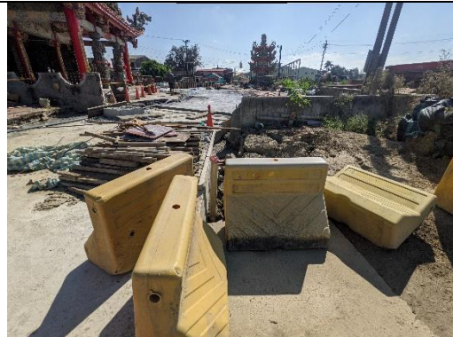
資材集中堆置區 (拍攝日期 110 年 11 月 17 日)
