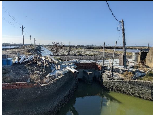
三寮灣聚落排水排水門預定處現況 (拍攝日期 110.12.28)
