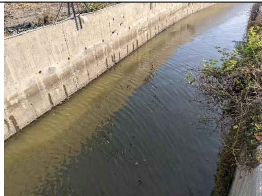
三慈排水現況 (拍攝日期 111.2.25)
