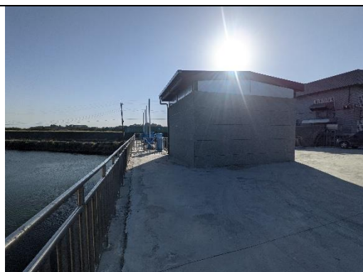
新圍抽水站之新建油槽室 (拍攝日期 110.10.25)
