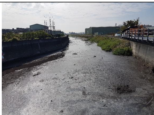
埤頭線排水現況 (拍攝日期 111.1.25)
