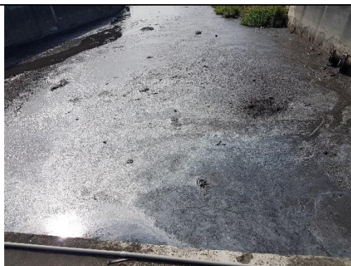
排水渠道內淤積嚴重 (拍攝日期 111.1.25)
