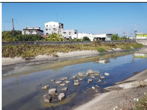
埤頭線排水現況 (拍攝日期 111.1.25)
