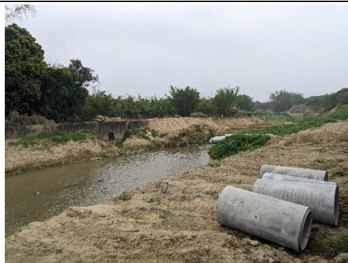
計畫範圍內整地後現況 ( 拍攝日期 111 年 3 月 29 日 )
