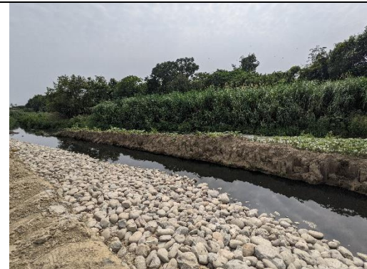
基腳椅放置拋塊石 (拍攝日期 110 年 10 月 26 日)
