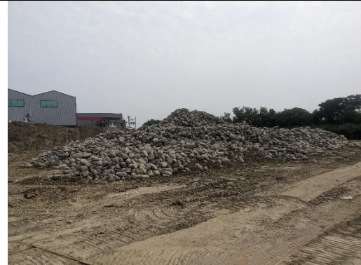
工程資材集中放置 (拍攝日期 110 年 10 月 26 日)
