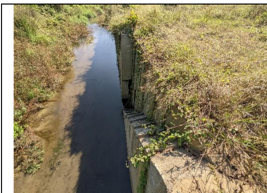
渡子頭排水現況 (拍攝日期 110.12.29)
