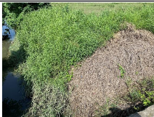
排水路內多有濱溪帶植物生長 (拍攝時間 110.7.21)
