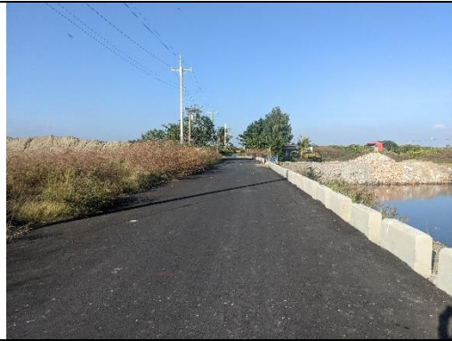
土城仔一之二排水旁新鋪設路面 (拍攝日期 110.11.17)
