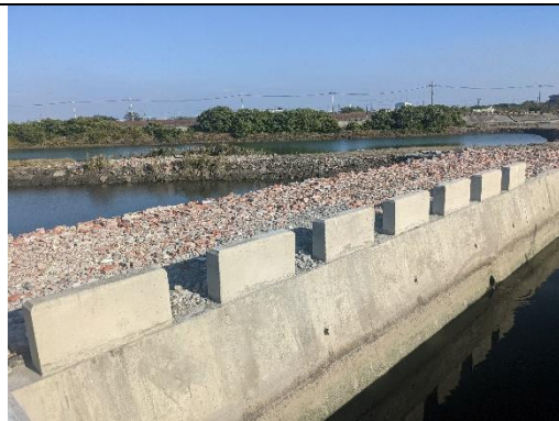
計畫之堤頂上現鋪滿碎磚 (拍攝日期 110.11.17)
