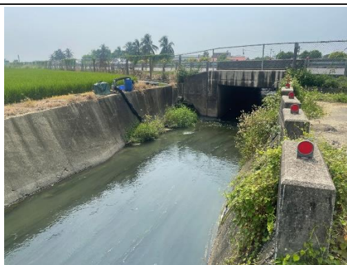
國道一號下方排水涵洞 (拍攝日期 110.9.22)
