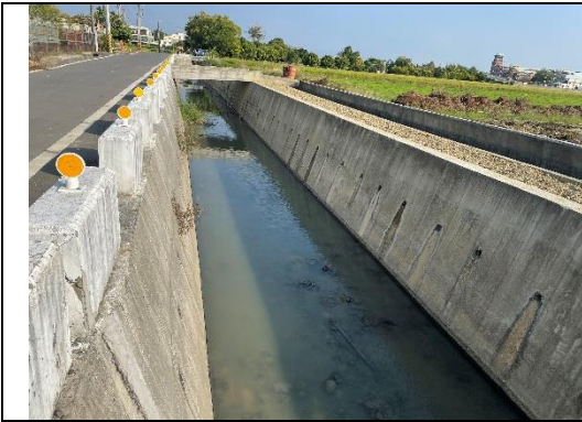
卯舍中排一工區現 (拍攝日期 110.11.19)
