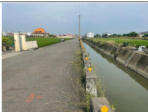
現有之堤頂道路 (拍攝日期 110.9.22)
