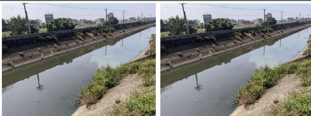
現況描述：現為坡面工的混凝土護岸型式，且以有植被生長至排水渠道邊
