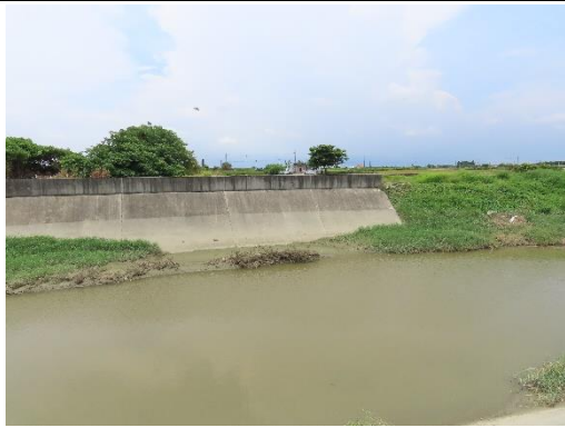
現有護岸為土堤結構 (拍攝時間 110.7.21)
