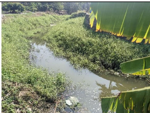
後鎮排水渠道內植被茂盛 (拍攝日期 111.2.25)
