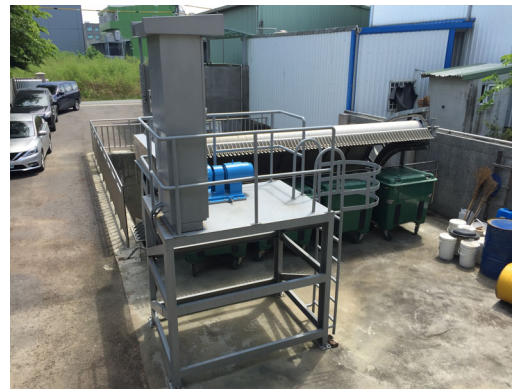
圖2-2-4 撈污機控制盤置於戶外
