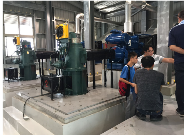
圖2-2-2 豎軸式抽水機2cmsx3
