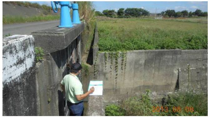
照片 5：竹後園中排一、竹後園中排二至抽水站有堤後排水側溝(W0.80mxH1.00m)連通
