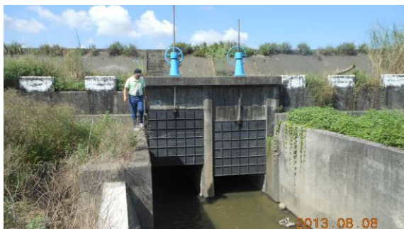
照片 7：竹後園中排一既有直提式手動閘門 (2xW2.0mxH2.0m)，水路渠寬約 4.5m。
